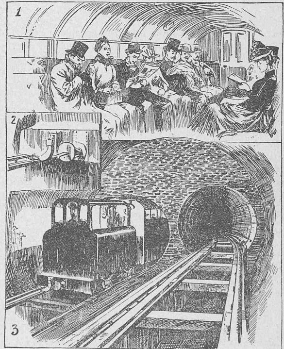
1. Inneres eines Personenwagens. 2. Verbindung der electricen Locomotiven mit der Leitung. 3. Mündung des Tunnels in eine unterirdische Station.
