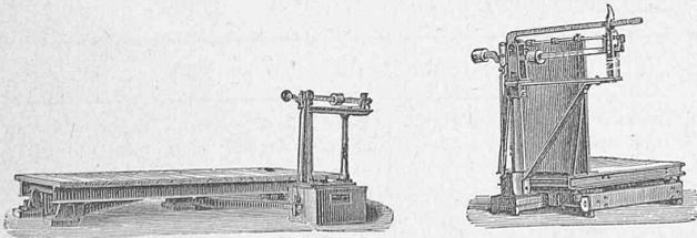
**Waggonwaagen ohne Geleisunterbrechung.**
