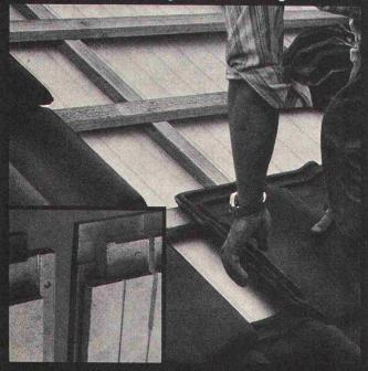
Isodach ist in zwei Stärken erhältlich: 55 mm, k-Wert 0,53 W/m<sup>2</sup>K (0,46 kcal/m<sup>2</sup> h °C) 80 mm, k-Wert 0,41 W/m<sup>2</sup>K (0,35 kcal/m<sup>2</sup> h °C)
