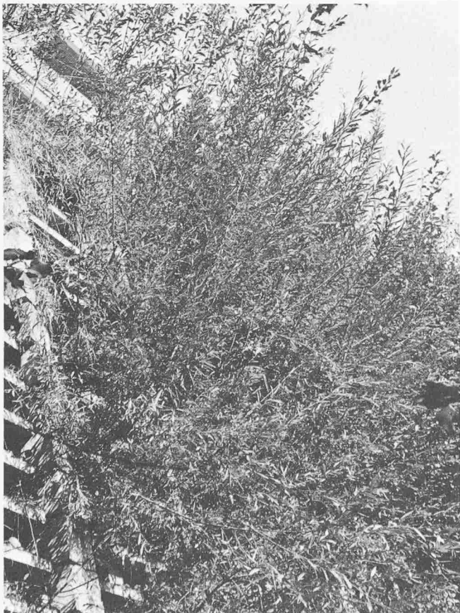
Bild 12 (links). Durch Einlegen lebender Weidenäste begrünzte Krainerwand aus Beton-Fertigteilen. 2 Jahre alt
