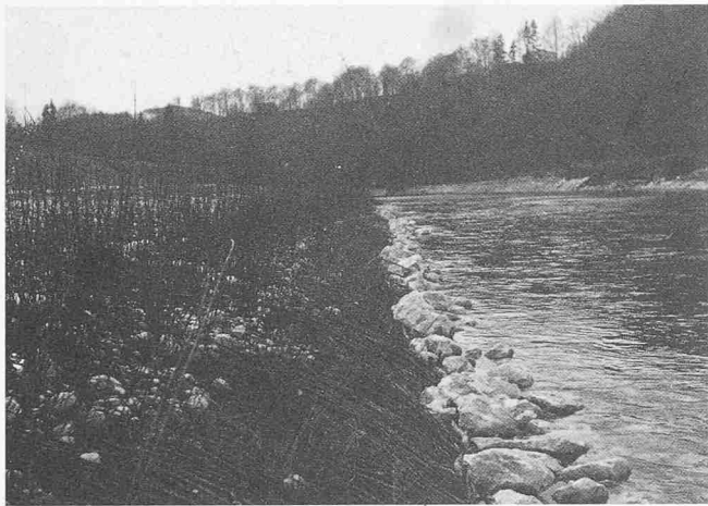
Bild 16. Ufersicherung durch Spreitlagenbau. Links: im Winter nach 1 Jahr; rechts: 9 Jahre alt
