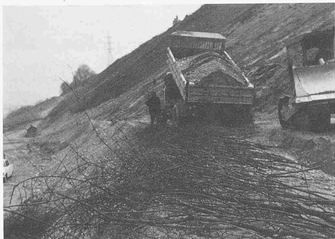
Bild 5. Buschlagenbau während der Schüttung
