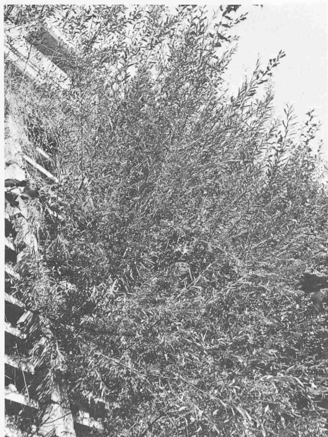
Bild 12 (links). Durch Einlegen lebender Weidenäste begrünte Kraierwand aus Beton-Fertigteilen. 2 Jahre alt
