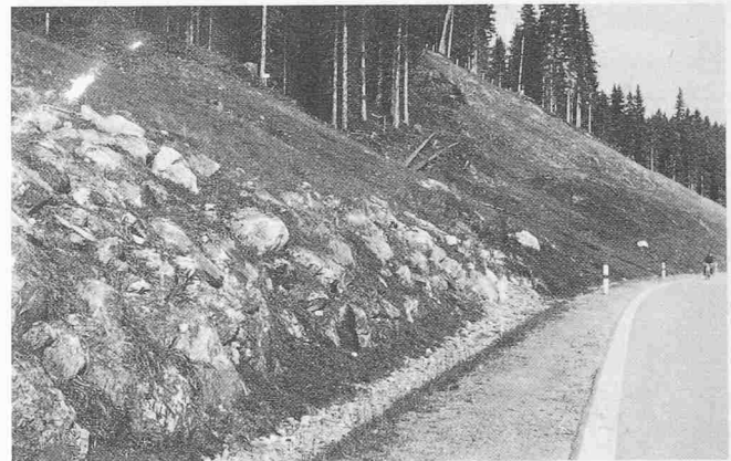
Bild 8. Abstützung einer durchnässten Strassenböschung mit einer Blockschichtung, mit Mulchsaat begrünt. 1 Jahr alt
