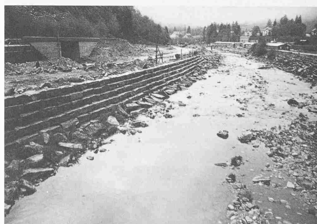
Bild 3. Aufwendige und schöne, aber schwer bepflanzbare Trockenblockmauer in Rodi-Fiesso. Hinten Trockenpflasterung, die leichter bepflanzbar ist
