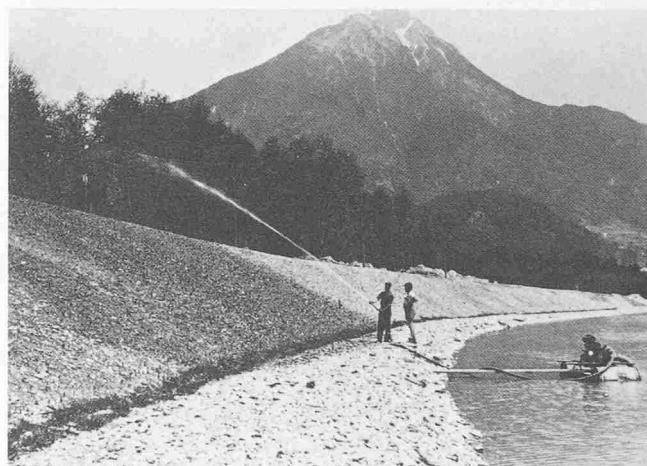
Bild 15. Ufersicherung durch Stecken von Weiden- und Pappelsteckhölzern. Oben während des Verpflanzens, unten 15 Jahre alt
