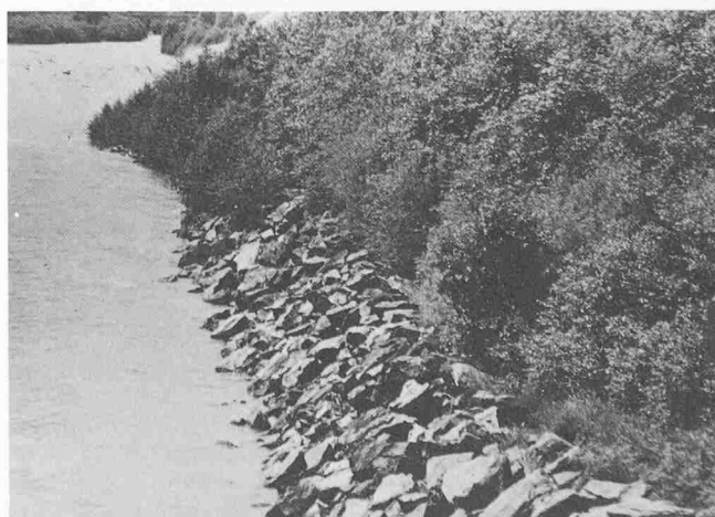
Bild 13 (unten). Blockwurf zur Ufersicherung, hier richtig flach geschüttet. Vorne nicht bepflanzt, hinten bepflanzt. 9 Jahre alt
