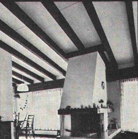
In **Neubauten** und **Altbauten** als **Dachschalung, Isolation** und **fertige Untersicht** in einem.
