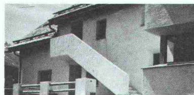
Beispiel einer gelungenen Sanierung eines Altbaues mit Renesco-Thermocrete-Wärmedämmputz (1800 m ü. M.)
