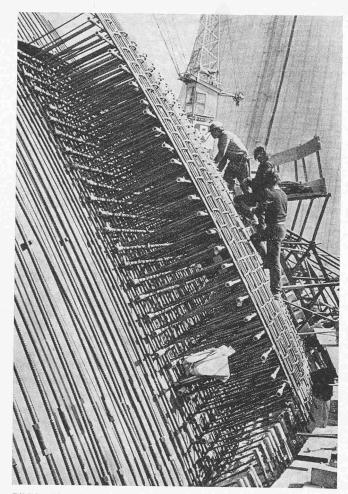
Bild 5. Kuppelbewehrung des Kernkraftwerkes Gösgen
