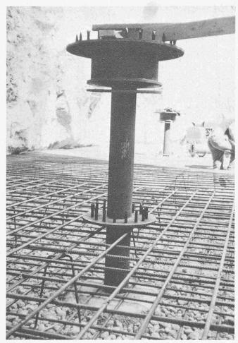
Stutzen für die Durchführung der Auftriebsanker durch die Fundamentplatten
