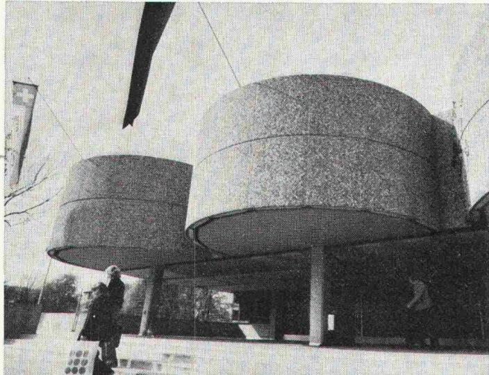
DURISOL-Fassadenelemente sind dreischichtig. Ein hochisolierender Kern wird beidseitig von einer Feinbeton- schicht umschlossen. Durch ein beson- deres Härtungsverfahren erhält die Aussenschicht ihre Wetterbeständigkeit und die helle Tönung. Sie wird weder gestrichen noch sonstwie behandelt, kann aber auch in Rippenbeton-, Wasch-
