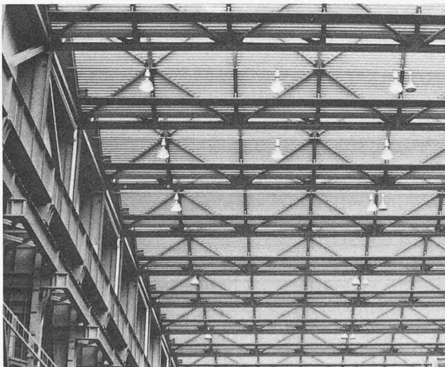
Bild 20. Innenansicht der Dachkonstruktion
