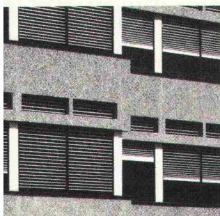
Die **Ganzmetall-Rafflamellenstore** wurde für höchste Anforderungen entwickelt und ist die ideale Kombination der Eigenschaften von Rolladen und Rafflamellenstoren.
