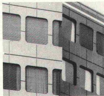
Die **Verbund-Rafflamellenstore VR 90** ist der erste Vertreter der neuen Storengeneration von Schenker mit automatischer Wippenverriegelung vorgegebener Arbeitsstellungen.
