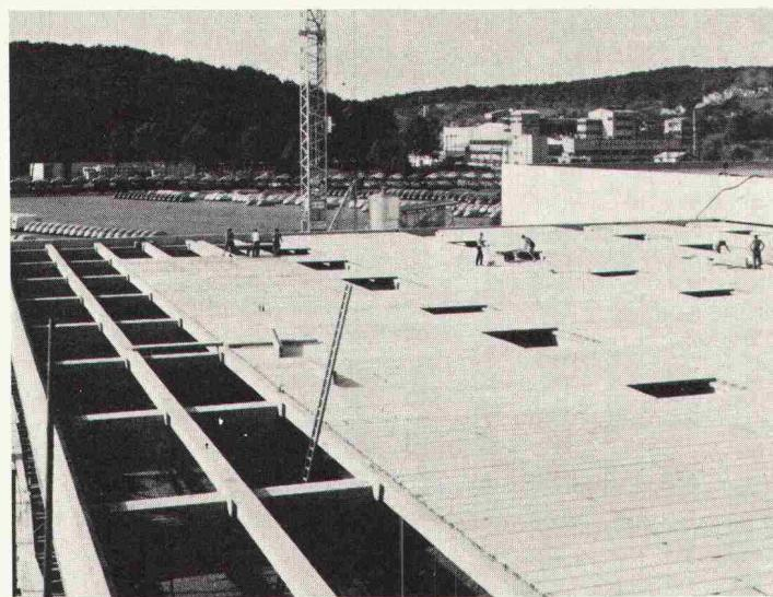
DURISOL-Dachelemente bestehen aus einem hochisolierenden Körper, der oben durch eine abtauchende Feinbetonschicht geschützt wird. Daraus resultiert die hervorragende thermische Isolationsfähigkeit. Der Erfolg der DURISOL-Dachelemente beruht
