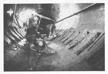
Bild 9. Vorgespannte Betonauskleidung als Sanierung des 11,4 km langen Druckstollens des Kraftwerkes Piastra-Andonno, Italien
