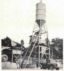
Standard-Betonanlagen AEBI, 4 Typen zwischen 20 m<sup>3</sup> und 60 m<sup>3</sup> Festbeton pro Stunde.
