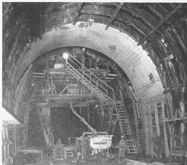
Schal- und Betonierinstallationen für die Auskleidung des Tunnels
