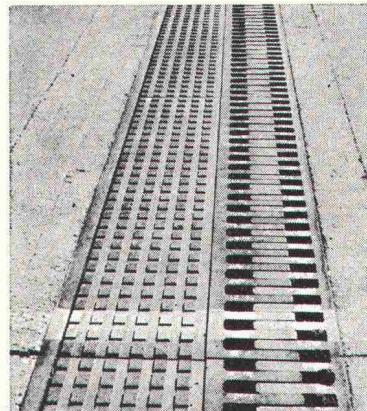
Wir erstellen die seit Jahren bewährten **Fahrbahn-übergänge** mit elastisch gelagerten Schleppblechen und zusätzlicher Dichtung der Schleppblechstöße. Unsere Fahrbahn-übergänge erfordern praktisch keinen Unterhalt.
