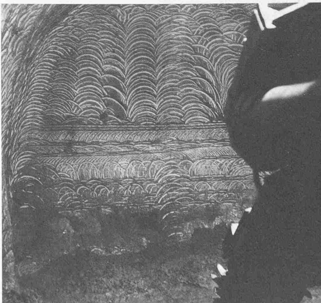
Bild 23. Gefräste Vortriebsbrust im Molassefels des Entlastungsstollens
