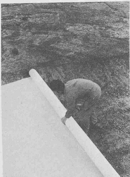
Auslegen eines Geotextils aus verwobenen Polypropylen-Folienbändchen. Man beachte die grosse Breite dieses Bauelementes
