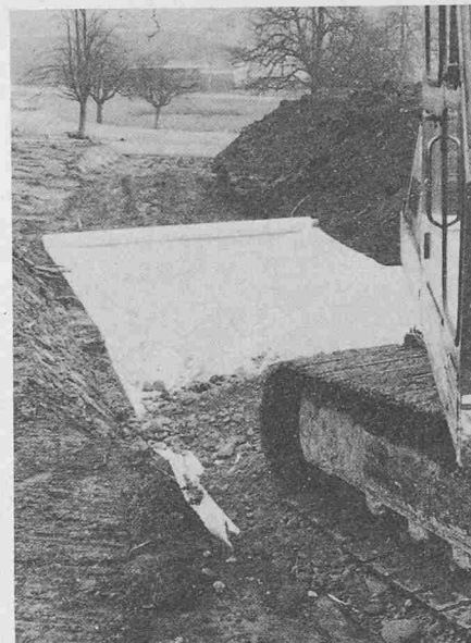
Detail aus der Baupiste. Das Geotextil ist ausgelegt. Der Bagger fährt bis an das Schüttungsende, um neues Material aufzuschütten
