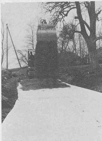
Auf schlechten Baugrund ausgelegtes Geotextil. Der Bagger schüttet direkt eine Belagschicht, auch für Fahrzeuge befahrbar
