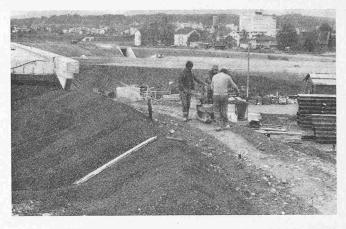
Bild 8. Verdichten des seitlichen Stützkörpers mit dem Plattenvibrator AT 2000
