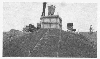
Bild 9. Versuchsanordnung beim Scherversuch
