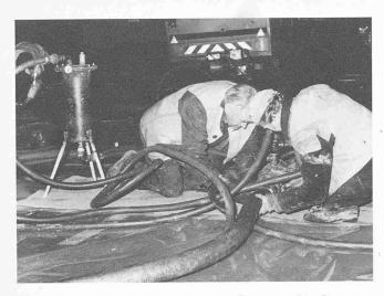
Anschliessen der Vakuum-Ausrüstung zur Reparatur einer Strasse
