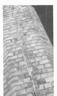
Links: Riss in einem Pfeiler einer Strassenbrücke
