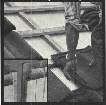
Isodach ist in zwei Stärken erhältlich: 55 mm, k-Wert 0,53 W/m2K (0,46 kcal/m2 h °C) 80 mm, k-Wert 0,41 W/m<sup>2</sup>K (0,35 kcal/m<sup>2</sup> h °C)
