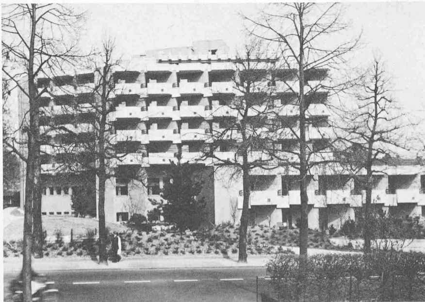
Unten: Ansicht von Südwesten; unten rechts: Teilansicht von Süden
