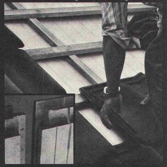
Isodach ist in zwei Stärken erhältlich: 55 mm, k-Wert 0,53 W/m²K (0,46 kcal/m² h °C) 80 mm, k-Wert 0,41 W/m²K (0,35 kcal/m² h °C)
