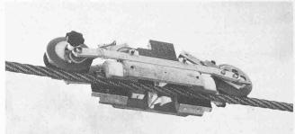
Das prüfbereite Defectoscop. Im Jahre 1969 wurde für die Tragseilprüfung eine pneumatische Schliess- und Abhebevorrichtung gebaut, wodurch sich die manuellen Montage- und Demontagearbeiten, die zu einer Stützenüberfahrt nötig waren, ausschalten liessen
