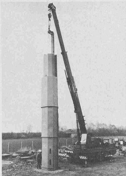
von Schwerpappe, Mineralfasern und genoppter Schaumstoffschicht. Für den Transport zur Baustelle lassen sich Mäkler und Schalldämmkamin in Einzelteile mit maximal 5,30 m Länge zerlegen.
