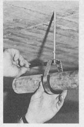
durch die Stabilität der Gewindestange werden die Pendelbewewegungen des Rohres wesentlich reduziert.
