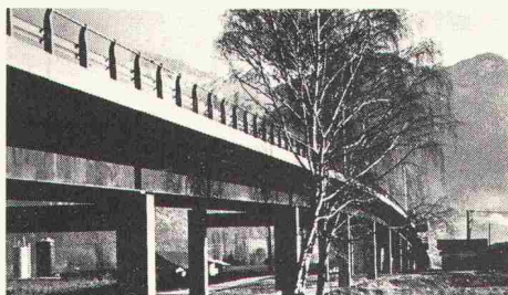
Strassenbrücke über eine in Betrieb stehende Eisenbahnstrecke
