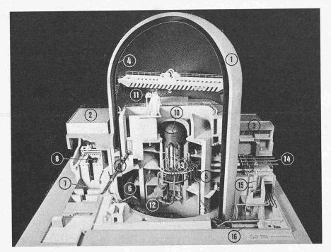
Modellaufnahme des Reaktorgebäudes und des angrenzenden Brennelementlager-Reaktorhilfsgebäudes mit einem zylindrischen Sicherheitsbehälter von 36,6 m Durchmesser
