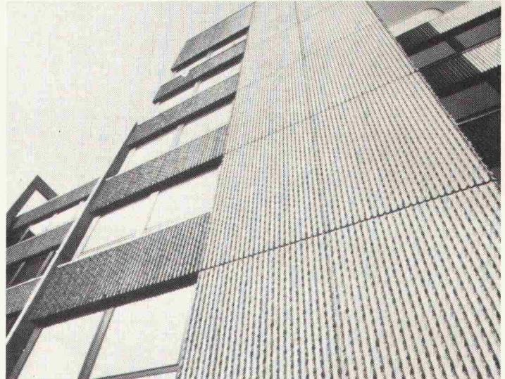
DURISOL-Fassadenelemente sind dreischichtig. Ein hochisolierender Kern wird beidseitig von einer Feinbeton- schicht umschlossen. Durch ein besonderes Härtungsverfahren erhält die Aussenschicht ihre Wetterbeständigkeit und die helle Tönung. Sie wird weder gestrichen noch sonstwie behandelt, kann aber auch in Rippenbeton-, Wasch-
