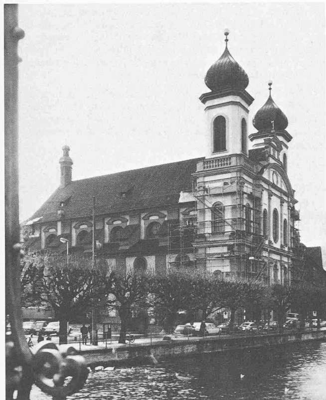
Fig. 1. Vue de l'église. L'échafaudage de la tour sert à la préparation des niches et à la mise en tension des câbles View of the church. The scaffolding is used to prepare the niches and to stress the cables
