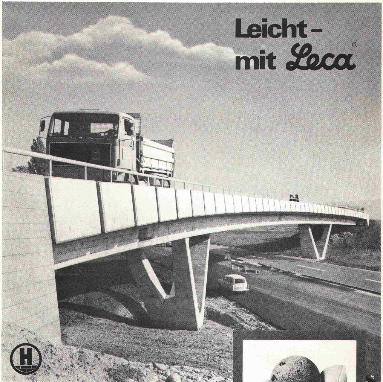
Brücke aus Leca hsd -Beton beim N 4-Anschluss «Mutzentäli», Schaffhausen Bauherr: Tiefbauamt des Kantons Schaffhausen Statik: Wehrli & Weimer, dipl. Bauing. ETH/SIA, Zürich Bauausführung: B. Ehrat-Osswald, Baugeschäft, Neuhausen am Rheinfall
