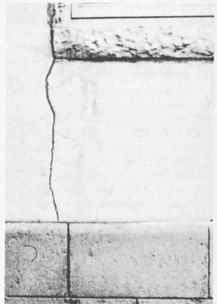
Bild 5. Thermische Risse
