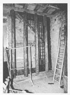
Bild 5. Armierung der neuen Wandscheibe im Erdgeschoss
