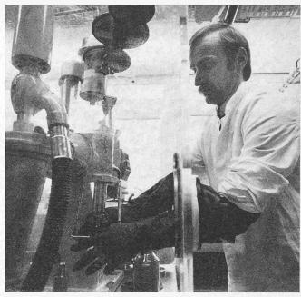
Bild rechts. Fein zermahlenes Berylliumpulver – das Ausgangsmaterial für gesintertes Berylliummetall – wird in der Windsichter genannten Trennanlage nach der Grösse der nur wenige Tausendstelmillimeter messenden Teilchen sortiert. Um das Entstehen von Berylliumoxid zu vermeiden, findet die Sinterung in ultrareiner Argonatmosphäre statt
