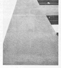
Rechts: Mängel in der Anstrichausführung. Rolleransätze durch ungleich dicke Farbschichten auf stark saugendem Spritzputz. Unter flachem Winkel betrachtet sind keine Strukturunterschiede im Verputz sichtbar.
