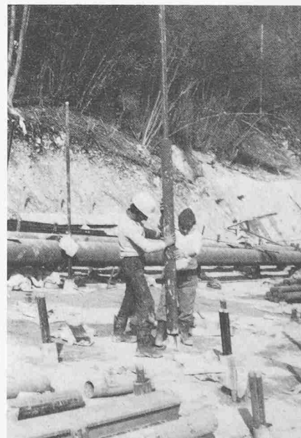
Bild 9 (links). Bohrgerät für Gefrierbohrungen
