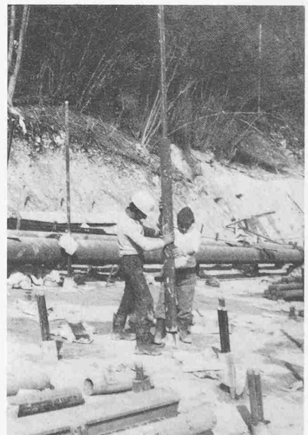
Bild 9 (links). Bohrgert für Gefrierbohrungen
