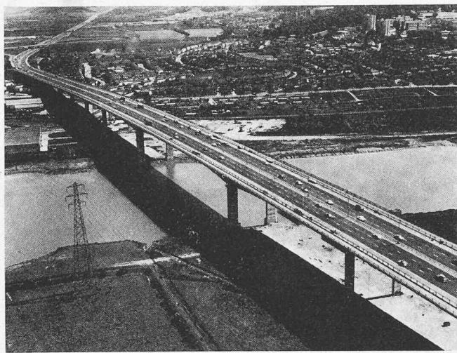
Die Brücke hat über dem Fluss eine Spannweite von 174 m, die anschliessenden 113 m langen Endteile bestehen aus doppelt geschweißten Stahlkastenträgern mit geschweißtem Stahldeck. Nach Ansicht der Preisrichter «verwertet die Konstruktion die Festigkeit, Leichtigkeit und Vielseitigkeit von Stahl im höchsten Masse, und die gut ausgeglichenen Proportionen des Unter- und Oberbaus bedingen ein wirtschaftliches und ästhetisch ansprechendes Ergebnis».
