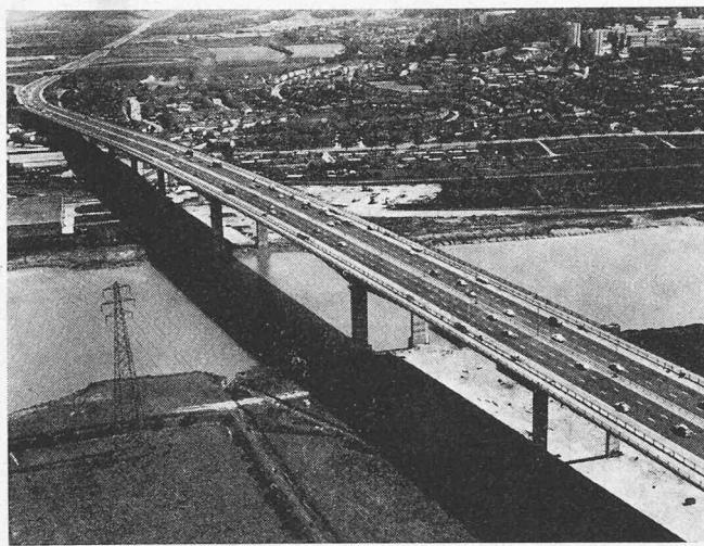
Die Brücke hat über dem Fluss eine Spannweite von 174 m, die anschliessenden 113 m langen Endteile bestehen aus doppelt geschweissten Stahlkastenträgern mit geschweisstem Stahldeck. Nach Ansicht der Preisrichter «verwertet die Konstruktion die Festigkeit, Leichtigkeit und Vielseitigkeit von Stahl im höchsten Masse, und die gut ausgeglichenen Proportionen des Unter- und Oberbaus bedingen ein wirtschaftliches und ästhetisch ansprechendes Ergebnis».
