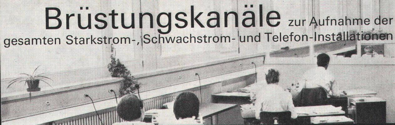
● für Aufputz- und Unterputz-Montage ● in Stahlblech mit kratzfester Kunststoffbeschichtung oder in eloxiertem Aluminium ● Frontplatten in Kunststoff oder in eloxiertem Aluminium
