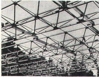
Stahlbauten sind leicht und luftig: Bei der Gross-Sporthalle in Magglingen überspannen Fachwerkträger mit 50 m Spannweite das Spielfeld und nehmen Schneelasten bis zu 300 kg/m<sup>2</sup> auf.
