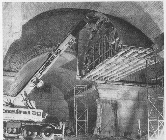
Bild 29 (links). Bindermontage. – Bild 31 (rechts). Einspielen und Absetzen der ganzen Schalungseinheit mit zwei Kranwagen in der zweiten Hauptkaverne
