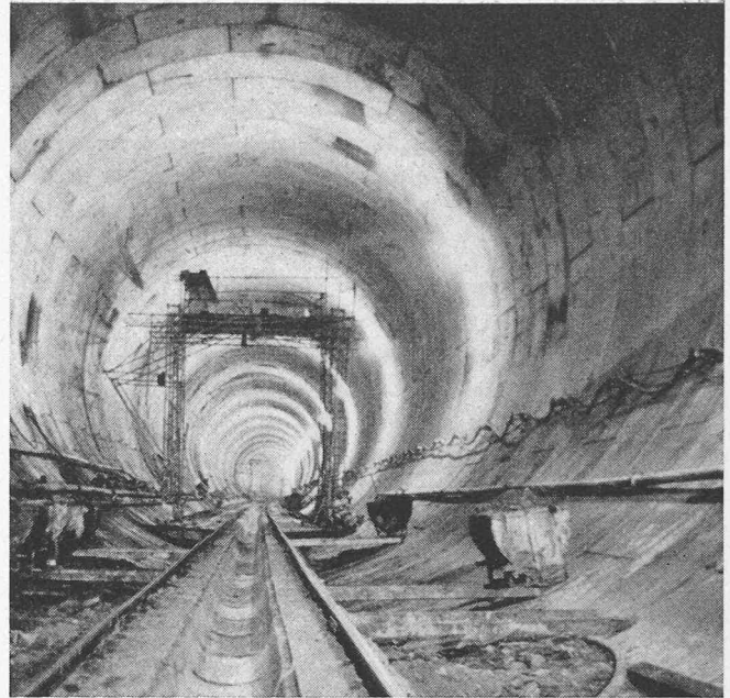
Bild 14 (links). Schild und Excavator nach Ankunft in der Zentrale. Unten links und rechts sind die Bankette sichtbar, auf die der Schild in der ersten Phase der Ummontage geschoben werden musste, damit der Stahlschlitten, auf dem die ganze Einheit von etwa 800 t verschoben und gedreht wurde, von vorne her untergeschoben werden konnte (Photostudio Z, Altdorf). – Bild 18 (rechts). Rückblick in die fertig eingebaute Tunnelröhre
