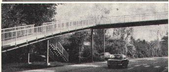
Im Verkehr geht Sicherheit über alles, besonders auf dem Schulweg, an stark frequentierten Strassenübergängen. Fussgänger-Passerellen von Tuch-schmid erhöhen die Sicherheit. Sie werden den örtlichen Verhältnissen angepasst, im Werk gefertigt und bei geringsten Verkehrsbeschränkungen innert wenigen Stunden montiert. Neben der guten Form überzeugt auch der günstige Preis. Unterbreiten Sie uns Ihr Problem, wir offerieren Ihnen die Lösung.
