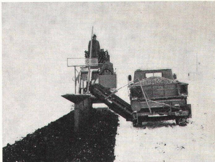
Bau von Rohrdrainagen mit Drainagemaschine. Grabenöffnung mit Fräse, Gefällsregulierung automatisch mit Laserstrahl-Nivellierung, Rohrverlegung und Einbringen des Grabenfiltermaterials werden in einem Arbeitsgang ausgeführt.
