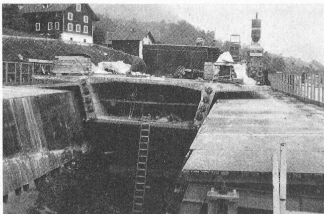
Bild 5. Aufnahme des Brückenquerschnittes bei der Koppelfuge K 2 kurz nach der ersten Vorschubetappe. Die Stege gehen mit konstanter Stärke durch. An dieser Stelle ist die Höhe reduziert, weil wegen des Anschlusses der Emmettenstrasse ein Voutenfeld ausgebildet wird. Die Voutenform ist an der Stegchalung links deutlich erkennbar. (Aufnahme: D. J. Bänziger, 14. 7. 1977)
