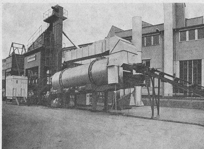
Motorensteuerungen sind auf den einzelnen Maschinengruppen aufgebaut. Steckbare Steuerkabel verbinden die Maschinen mit dem Steuerpult in der Kommandokabine. Generatorgruppen garantieren die unabhängige Stromversorgung.
