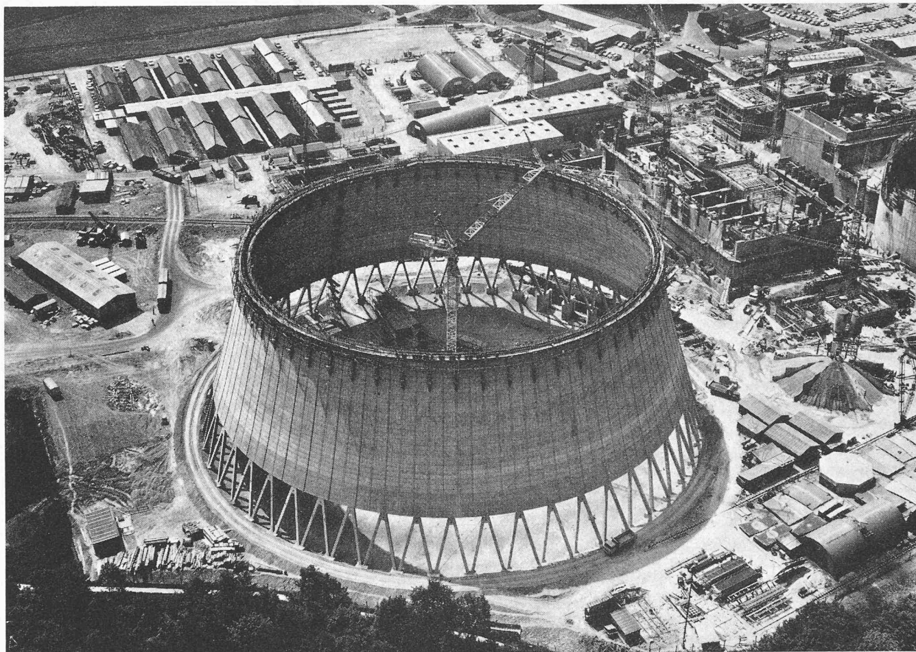
Bild 11 (oben). Kletterschalung und Betonier- vorgang mit Hilfe des zentralen Turmdreh- kranes (Comet-Photo)
