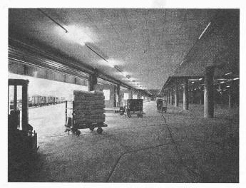
Umschlagplatz im Erdgeschoss. Kettenförderanlage mit Nordrampe
