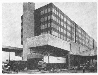
Ansicht Süd-West. Auskragung der Kranbahn für den Transcontainerumschlag
