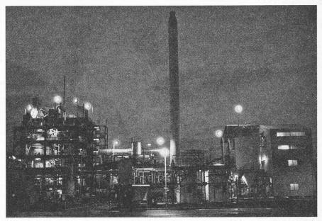
Bild 5 (links). Ko-Kneter-Anlage zur Herstellung von Kohleelektrodenmasse aus Koksen verschiedener Körnung mit Pech als Bindemittel. Praktisch alle in Europa und viele in Übersee gebaute Elektrodenfabriken für Aluminiumhütten sind mit solchen Anlagen ausgerüstet
