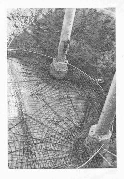
einer gut verteilten schlaffen Bewehrung empfiehlt. Fürdie 30 cm starken Senkdecken wurden daher in den Gurtstreifen je 4 VSL-Spannglieder zu je  $V_0=35$  t angeordnet (Bild 9), was einer Schwerpunktvorspannung von nur 6 kg/cm² entspricht.
