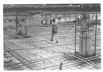
Bild 9. Gurtstreifenvorspannung der Zwischendecken
