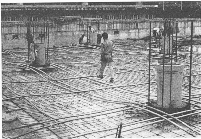
Bild 9. Gurtstreifenvorspannung der Zwischendecken
