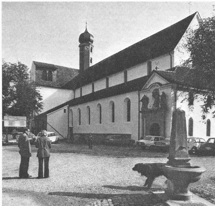
Nordseite der Kirche nach der Renovation 1976
