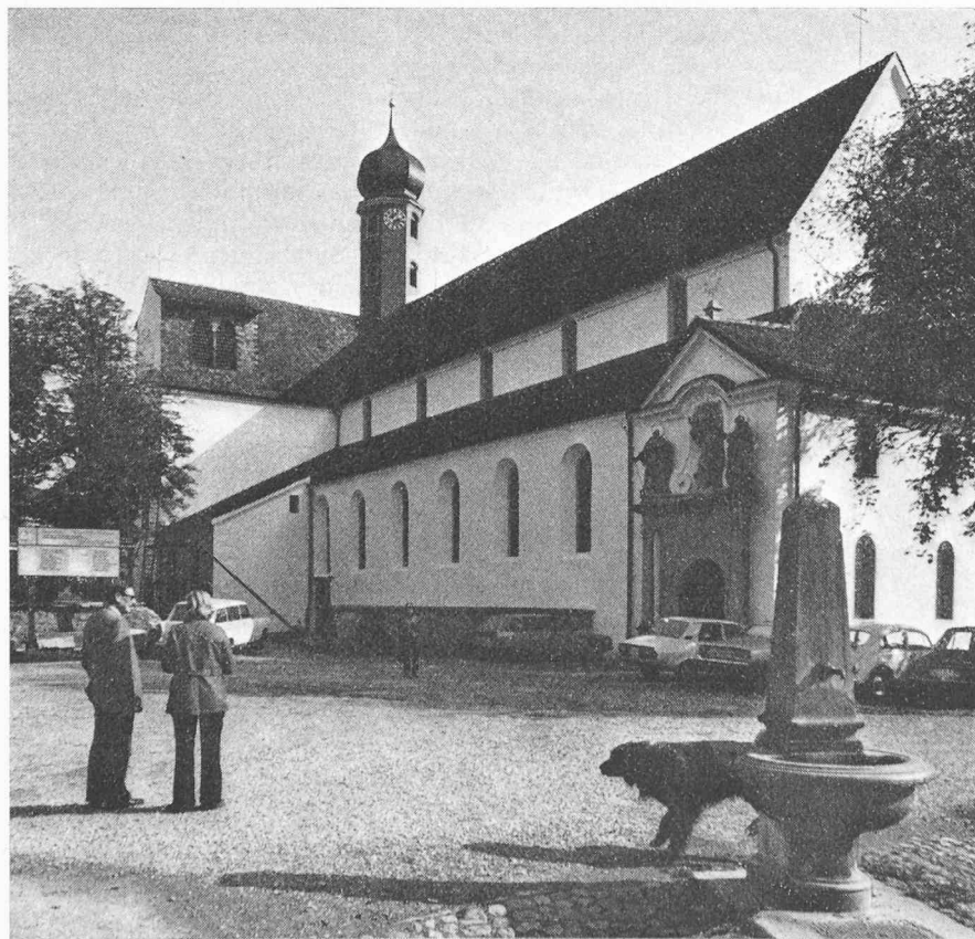
Nordseite der Kirche nach der Renovation 1976
