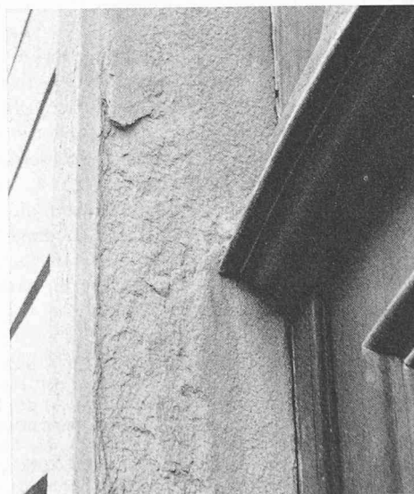
Rechts: Sandstein mit stehendem Lager – Fehler in der Verwendung von Baustoffen führen zu einer schnellen technischen Alterung
