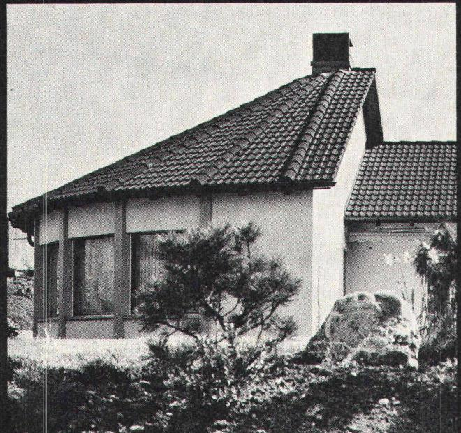
Der Braas-Redland Pfannenziegel wird mit glatter oder besandeter Oberfläche hergestellt. Der besandete Ziegel eignet sich besonders für Höhenlängen über 800 m, da er wirksam das Abgleiten von Schnee verhindert.
